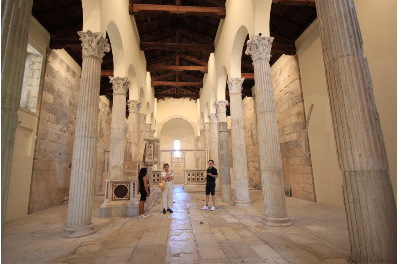
Colonnato romano del tempio/chiesa
