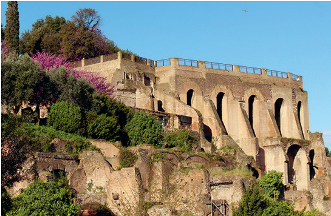
Domus Tiberiana sul Palatino: sostruzioni nord, vista da nord est (ph Ufficio fotografico del Parco archeologico del Colosseo)
