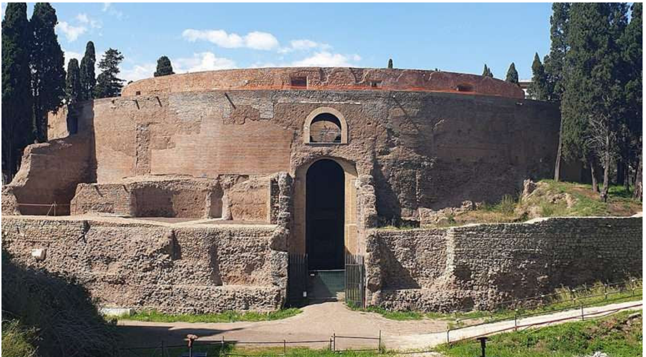
L'ingresso del Mausoleo restaurato: un tempo sveltava a 45 metri d'altezza, sorreggendo
