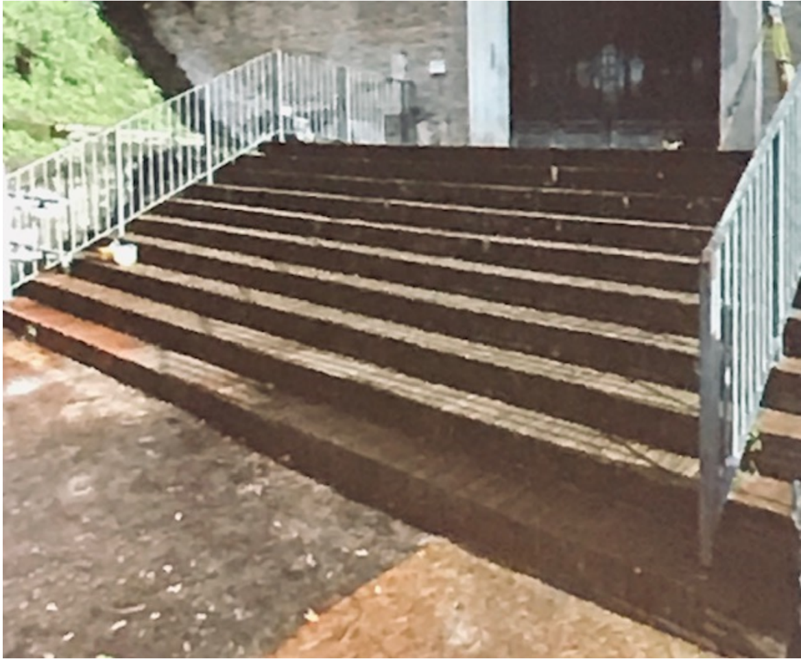
La scalinata d'accesso alla Curia Iulia costruita negli anni Trenta dal Bartoli, oggi smontata
